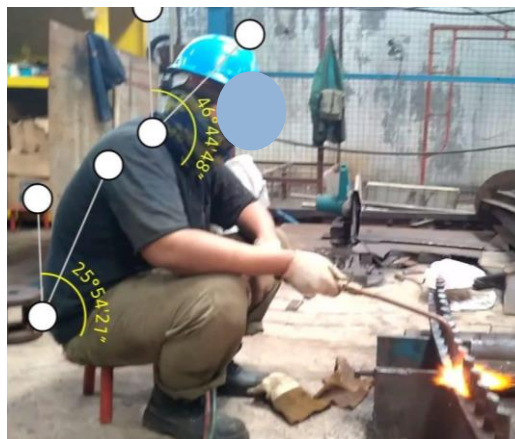
Gambar 2. Pekerjaan pengelasan pada workshop mechanical repair
